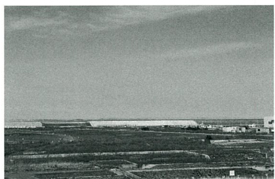
写真1 関上に再建中の防波堤
