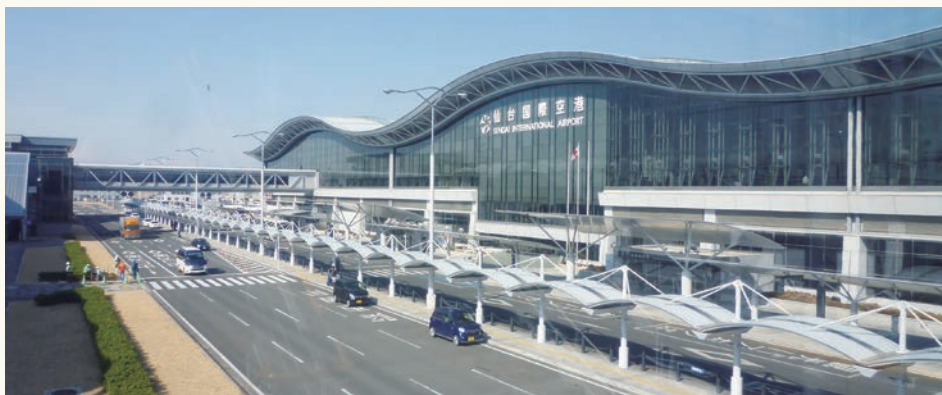
震災当日、多くの避難者を受け入れた仙台空港旅客ターミナルビル
